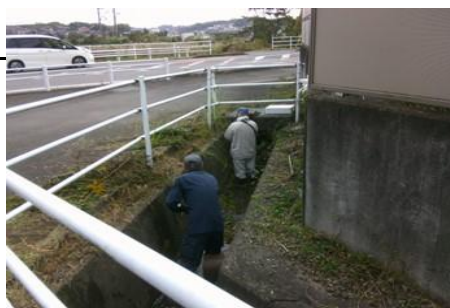
水路周辺の清掃
