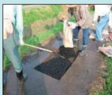
農道の部分補修
