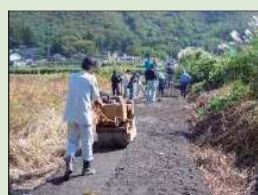
未舗装農道の舗装
