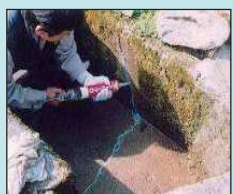
ひび割れの補修
