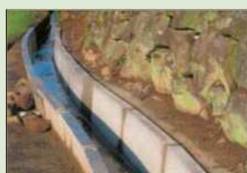
素堀り水路からの更新
