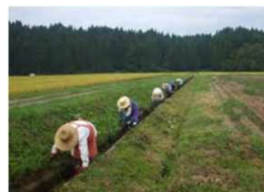
水路の泥上げ
