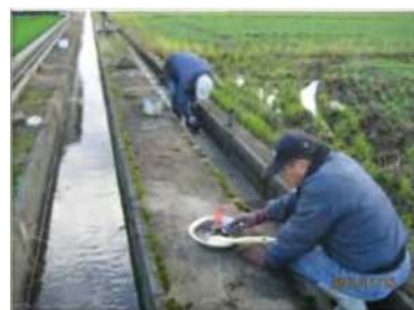
自主施工による目地補修
