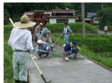
農道のコンクリート舗装
