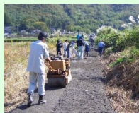
未舗装農道の舗装
