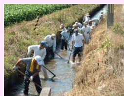
水路の泥上げ
