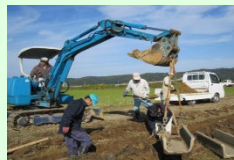
コンクリート水路の更新
