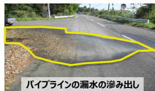
パイプラインの漏水のしみ出し
