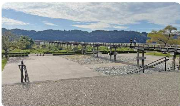
蓬萊橋土地改良区が管理する農道橋
