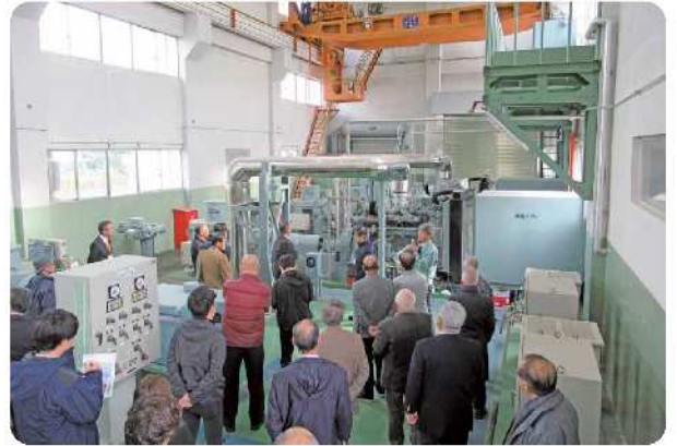
射水西部排水機場
