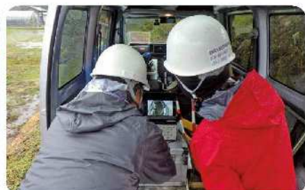
二次調査(管路:カメラ等による調査)
