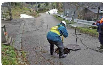
一次調査(管路:ミラー等による調査)
