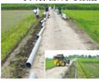
開水路の管路化
