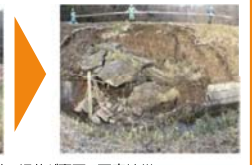
原形復旧したため池の堤体が豪雨で再度被災
