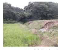
原形復旧したため池の堤体が豪雨で再度被災
