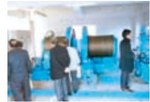
安濃ダム取水設備
