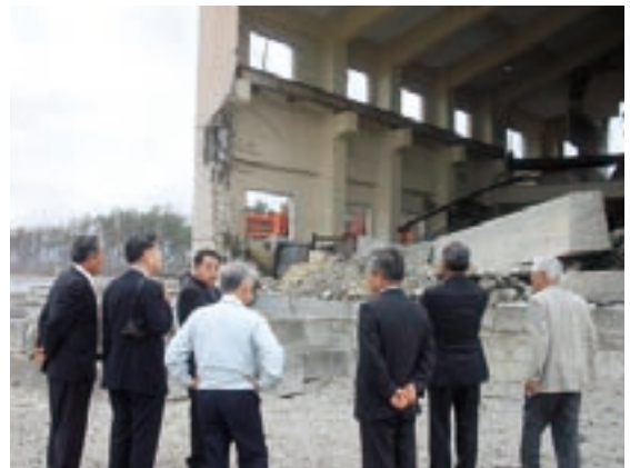
破壊された花笠第2排水機場
