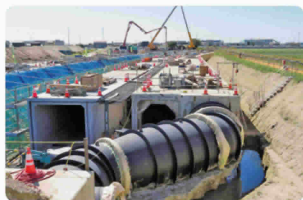
明治本流耐震化工事
