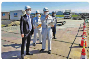
明治本流耐震化工事
