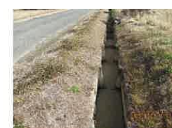
泥上げ作業終了
